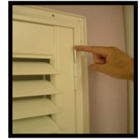
Insert Hinge Pin
