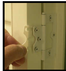
Insert hinge spacer
